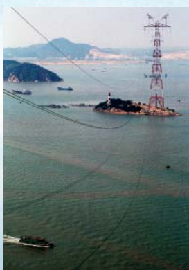
Travessia do rio Hangzhou, China (2001) Vão de 1.200 m / isoladores 400 kN
